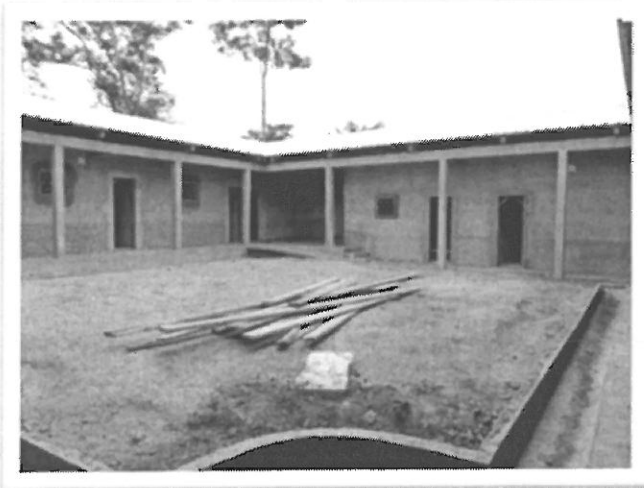
Lomié- Lavori in Corso dello studentato
