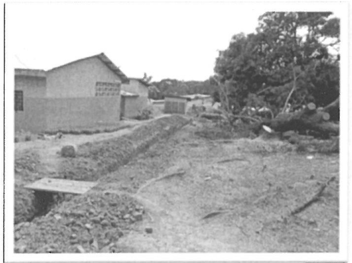
Talba – Lavori in corso per lo studentato femminile
